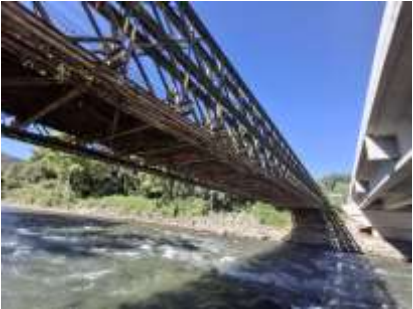
26 Fotografía No.1. Vista Lateral del Puente sobre el río Pejivalle.
