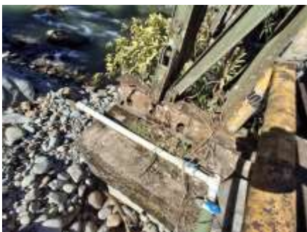
Fotografía No.5. Vista de los apoyos.
