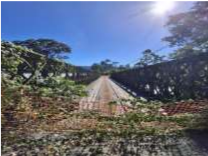
3 Fotografía No.2. Vista por línea centro.
