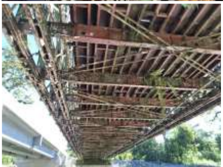
Fotografía No.6. Vista Inferior.
